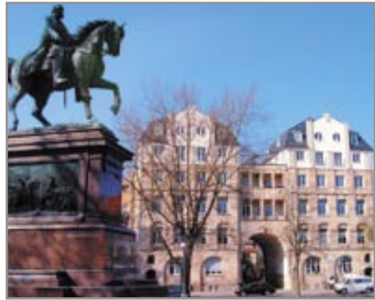
»Kulturdenkmal am Kaiserplatz« Sanierung und Aufstockung im Jahr 2000/01. Bürositz Bayerl Baukonzept GmbH
